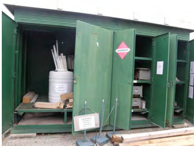
Слика 49 - Привремено складиште опасних отпадних материја "Електрошумадија" Крагујевац
